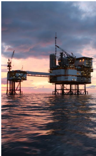
Plate-forme gaz naturel en mer du Nord
